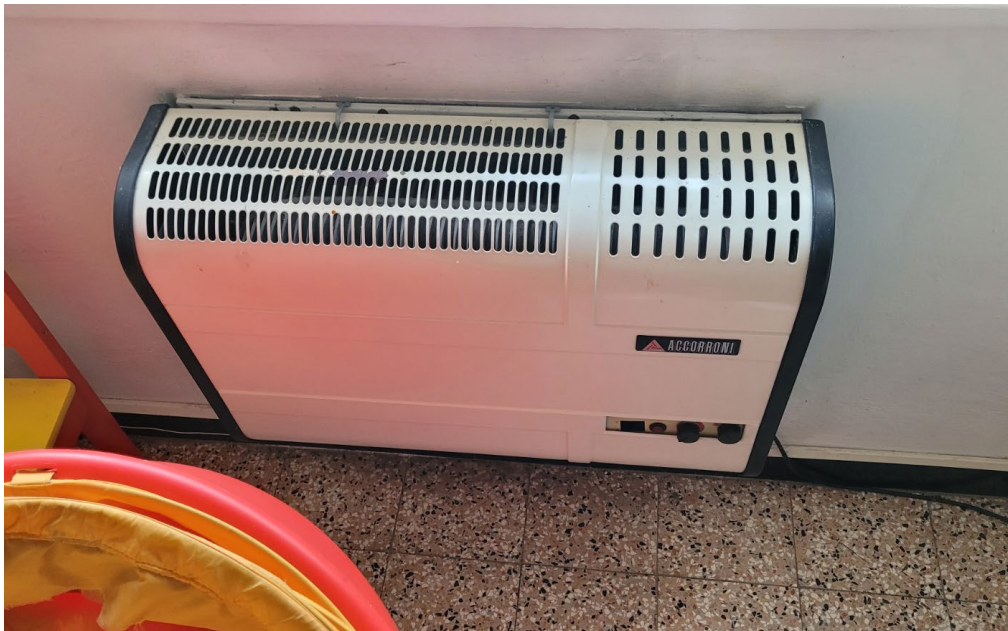
Radiatore a gas al piano primo (da rimuovere)
