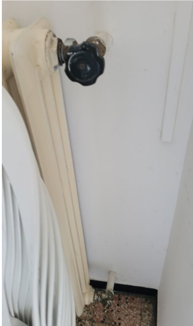
Dettaglio valvola e detentore del radiatore in ghisa
