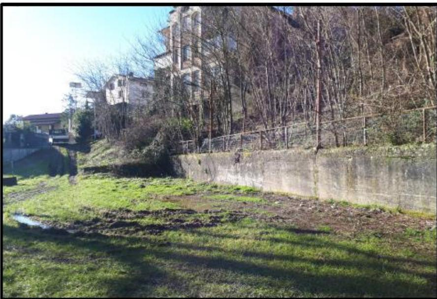
Il campo esistente è di ridotte dimensioni e, oggi, è pressochè in disuso: nella parte occidentale è delimitato da un muro in c.a. su cui sono posizionati tre pali di un impianto di illuminazione non più funzionante, mentre altri due si trovano sul lato opposto e anch'essi non sono più funzionanti. Sullo stesso lato del campo è presente una costruzione in legno adibita a locale deposito.
